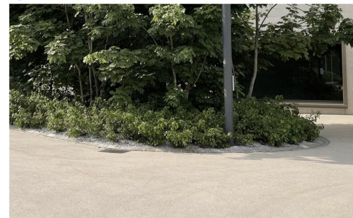
Chilbiplatz: robuster Asphalt oberflächenbehandelt mit farblosem Bitumen
