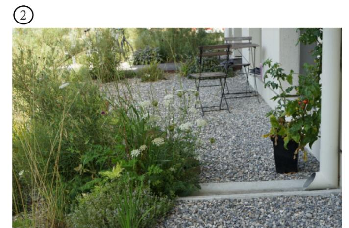
Regengärten mit angeschlossenen Fallrohren (Dachwasser)
