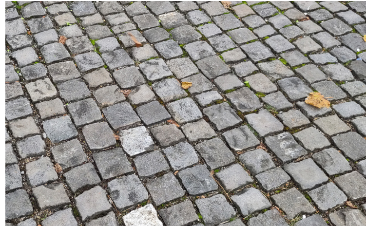
Adler: wertige Natursteinpflasterung mit offenen Fugen, barrierefrei verlegt
