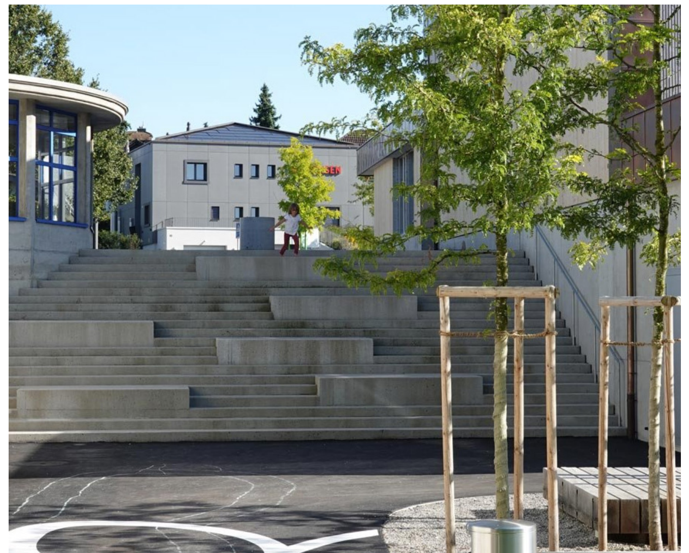
Treppenanlage und Baumpflanzung schafft Aufenthaltsqualität und Beschattung
