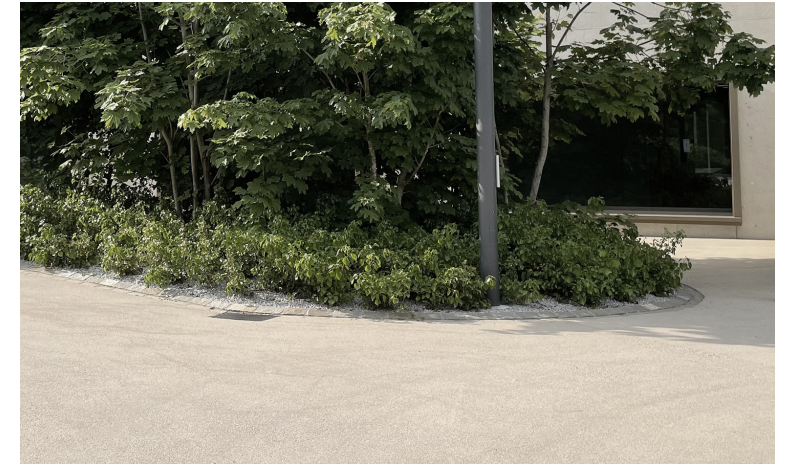
Chilbiplatz: robuster Asphalt oberflächenbehandelt mit farblosem Bitumen
