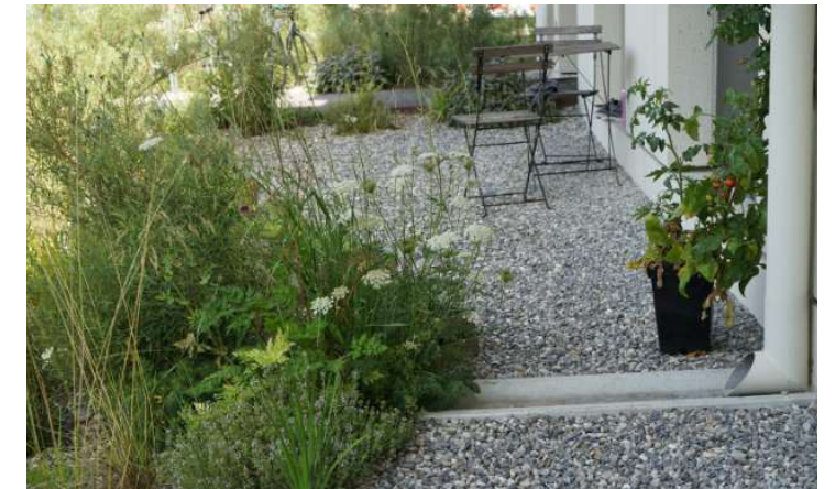
Regengärten mit angeschlossenen Fallrohren (Dachwasser)
