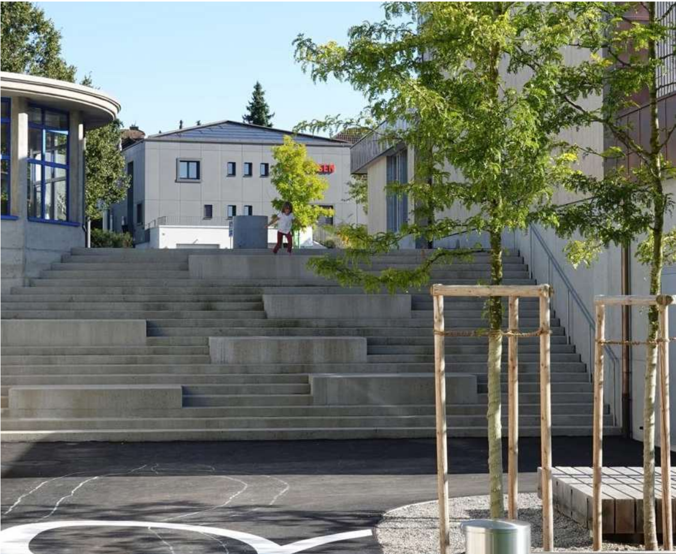
Treppenanlage und Baumpflanzung schafft Aufenthaltsqualität und Beschattung
